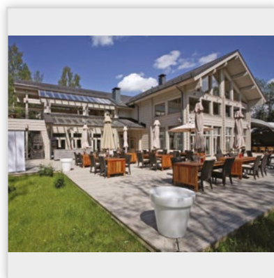
Findrewno, Budynek restauracyjny wraz z zapleczem kuchennym. Powierzchnia: 350 m 2 . Ściany wykonane z bali klejonych grubości 204 mm.
